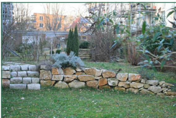
Een muurtje opgebouwd uit recuperatiestenen (Vauban, Freiburg (D.)). Bron: VIBE
