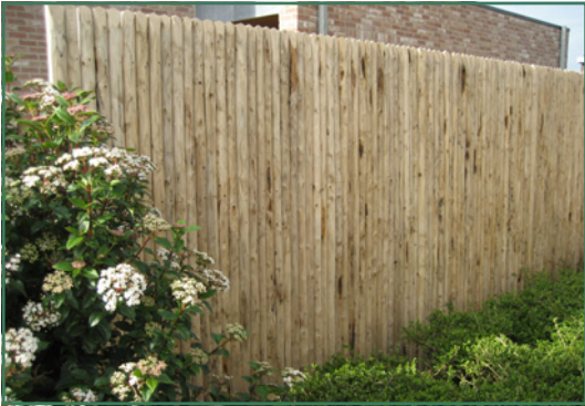
Een houten terreinafsluiting uit streekeigen hout (kastanje) Bron: Ecofence
