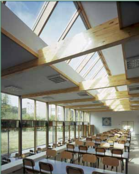
Gelamelleerde dragende spanten in het HIMM, architect Alexis Versèle
