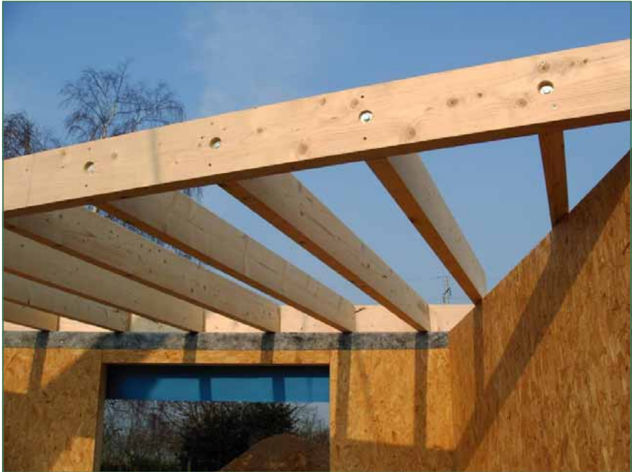
Architect Bruno Deraedt - Als een houtsoort met duurzaamheidsklasse I, II of III wordt gebruikt, is preventieve chemische verduurzaming overbodig.
